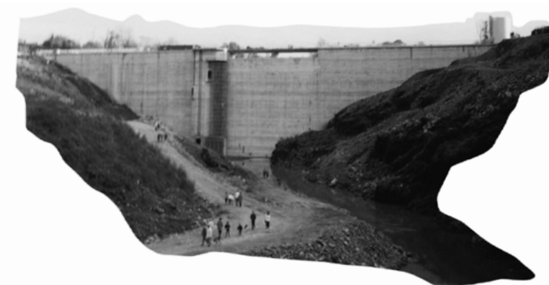
Inauguration du barrage de la Touche-Poupart, avant mise en eau, 1995
